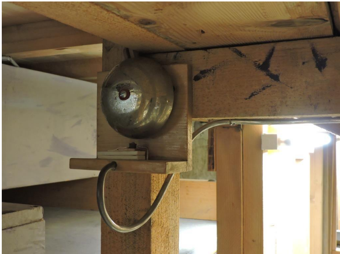
Abb. 311: Schwyz SZ, Kollegium (Opus 400, 1912/1913), Calcantenruf als Schalenglöckchen (Bernhard Hörler).
