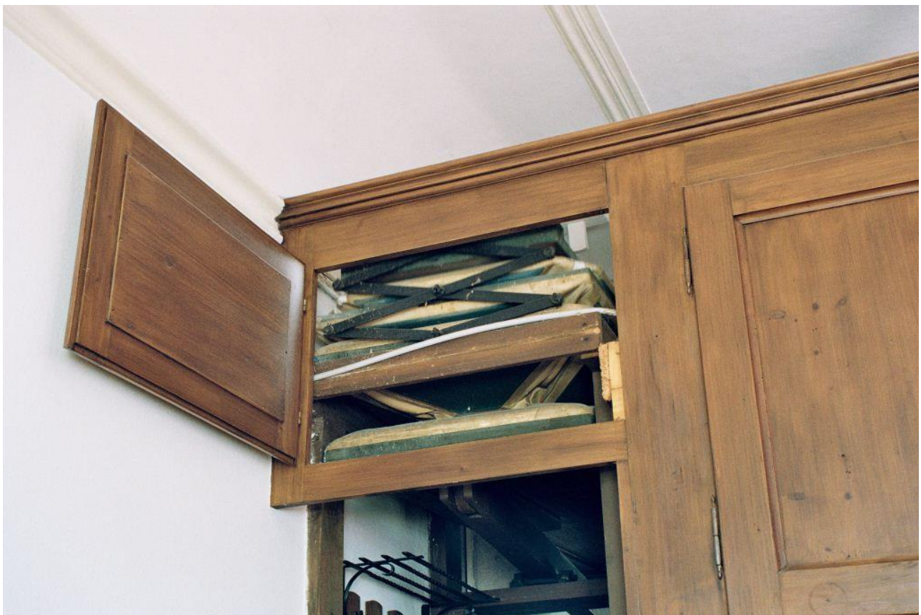
Abb. 290: Pleigne JU (Opus 66, 1888), die Balganlage hinter der Orgel (Bernhard Hörler).
