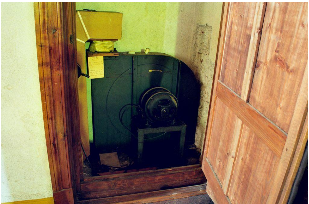
Abb. 314: Alassio (Italien), ehemalige anglikanische Kirche (Opus 332, 1908/1909), der Motor der Basler Firma Meidinger, der damals wohl bekanntesten Firma für Orgelmotoren (Bernhard Hörler).
