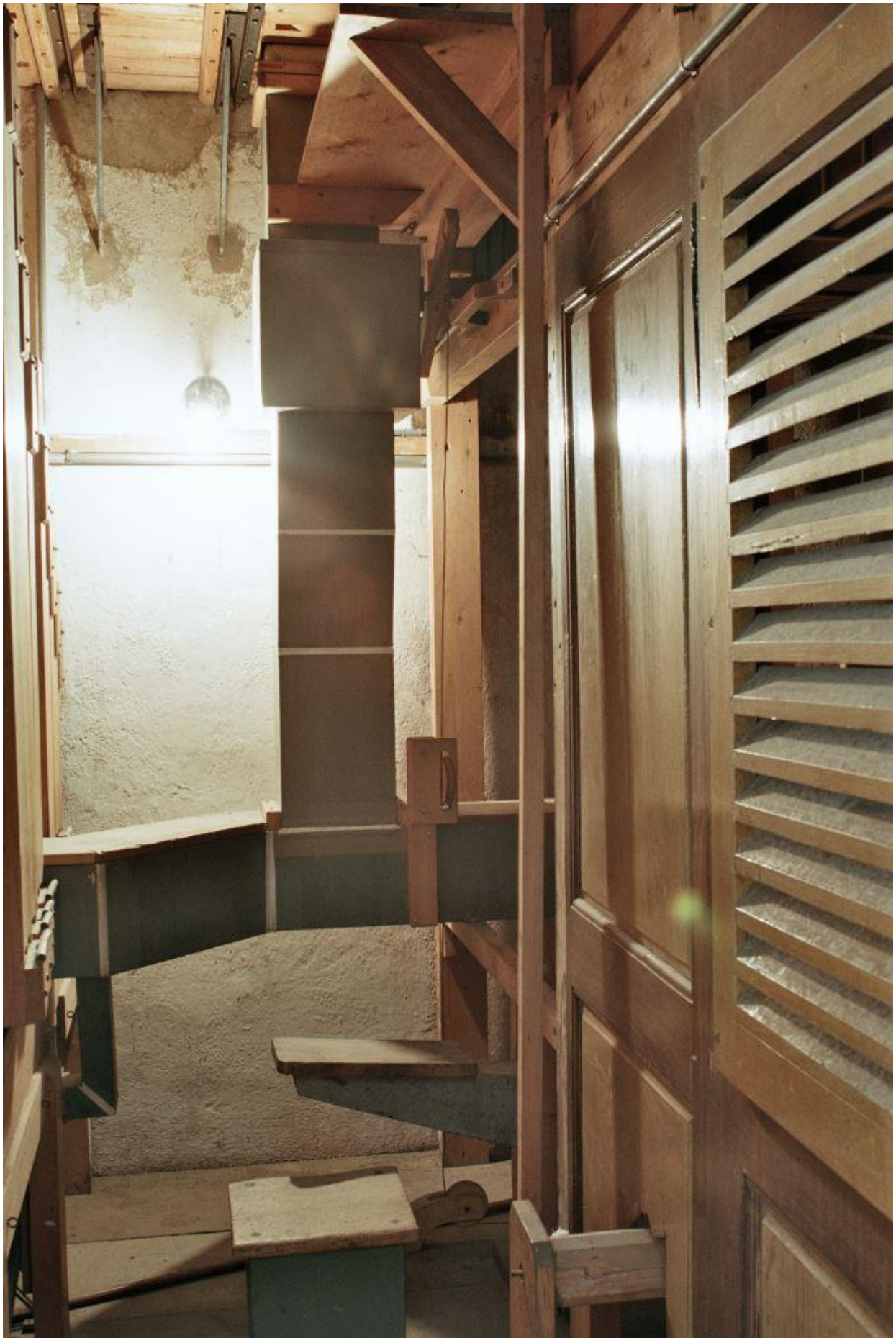
Abb. 294: Vevey VD, Ste-Claire (Opus 181, 1898), die Tretvorrichtung mit nur einem Schöpfer (Bernhard Hörler).
