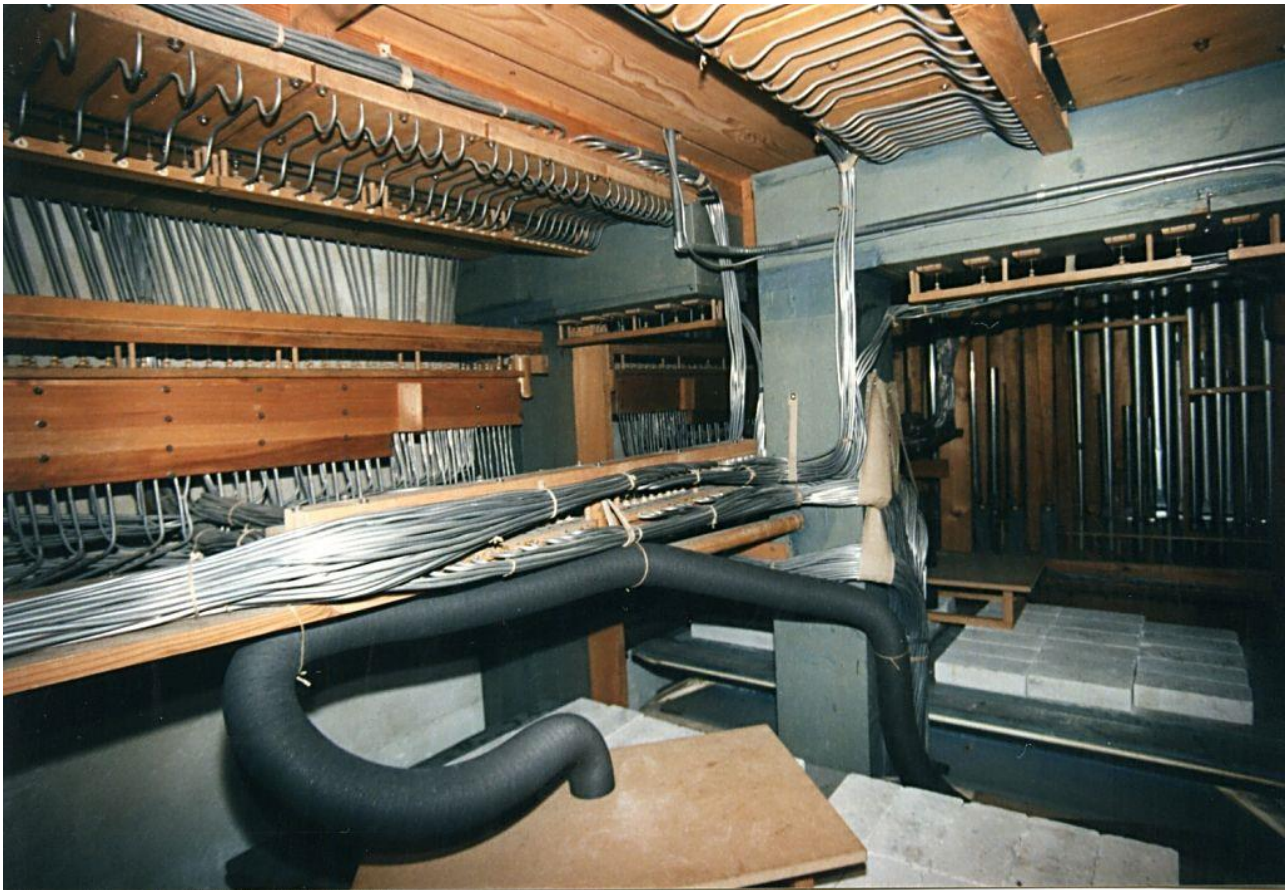
Abb. 169: Kriegstetten SO (Opus 535, 1922), die pneumatische Anlage (Bernhard Hörler).
