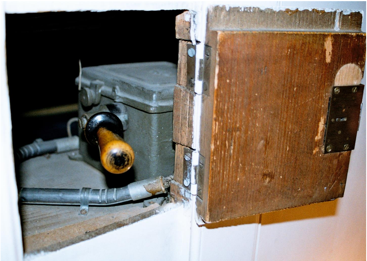
Abb. 315: Metzlerlen SO (Opus 535, 1922), der originale Motorschalter mit Holzgriff (Bernhard Hörler).
