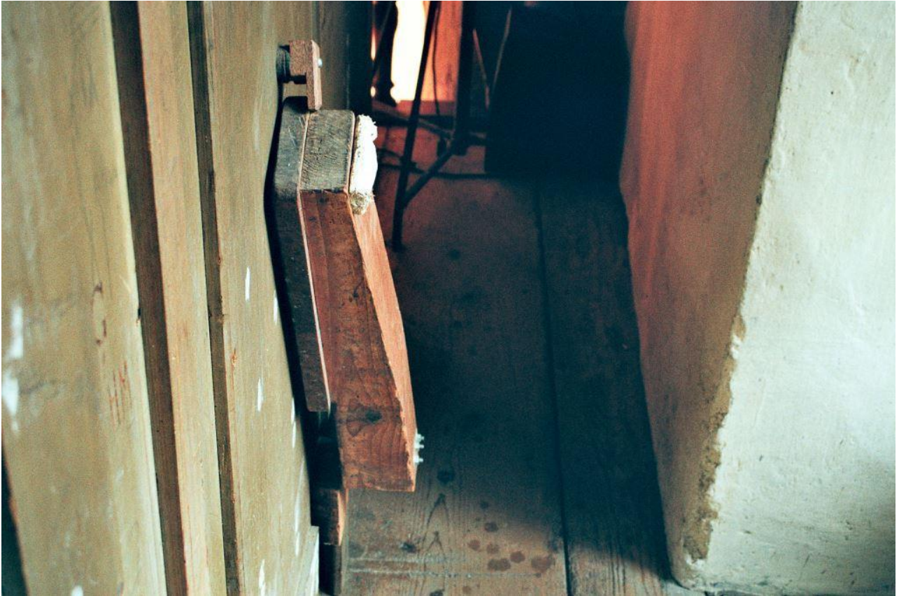
Abb. 291: St-Saphorin VD (Opus 73, 1889), die Tretvorrichtung in eingeklapptem Zustand (Bernhard Hörler).
