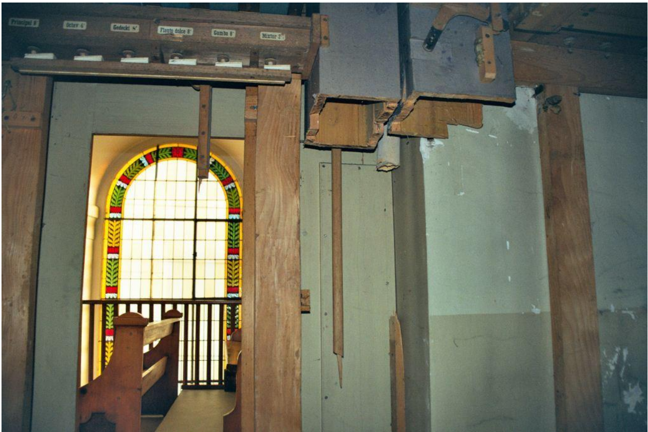
Abb. 375: St-Imier BE, christkatholische Kirche, die abgebrochenen Stangen der Calcantenanlage und zwei abgesägte Windkanäle in der zerstörten Goll-Orgel von 1912 (Bernhard Hörler).
