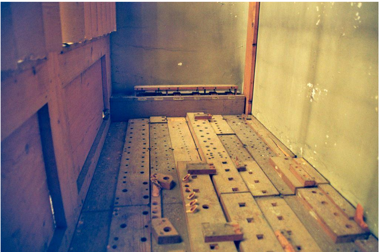
Abb. 377: St-Imier BE, christkatholische Kirche, Blick ins Schwellwerk der zerstörten Goll-Organ von 1912 – in der Mitte sind die abgesägten Kondukte gut zu erkennen (Bernhard Hörler).
