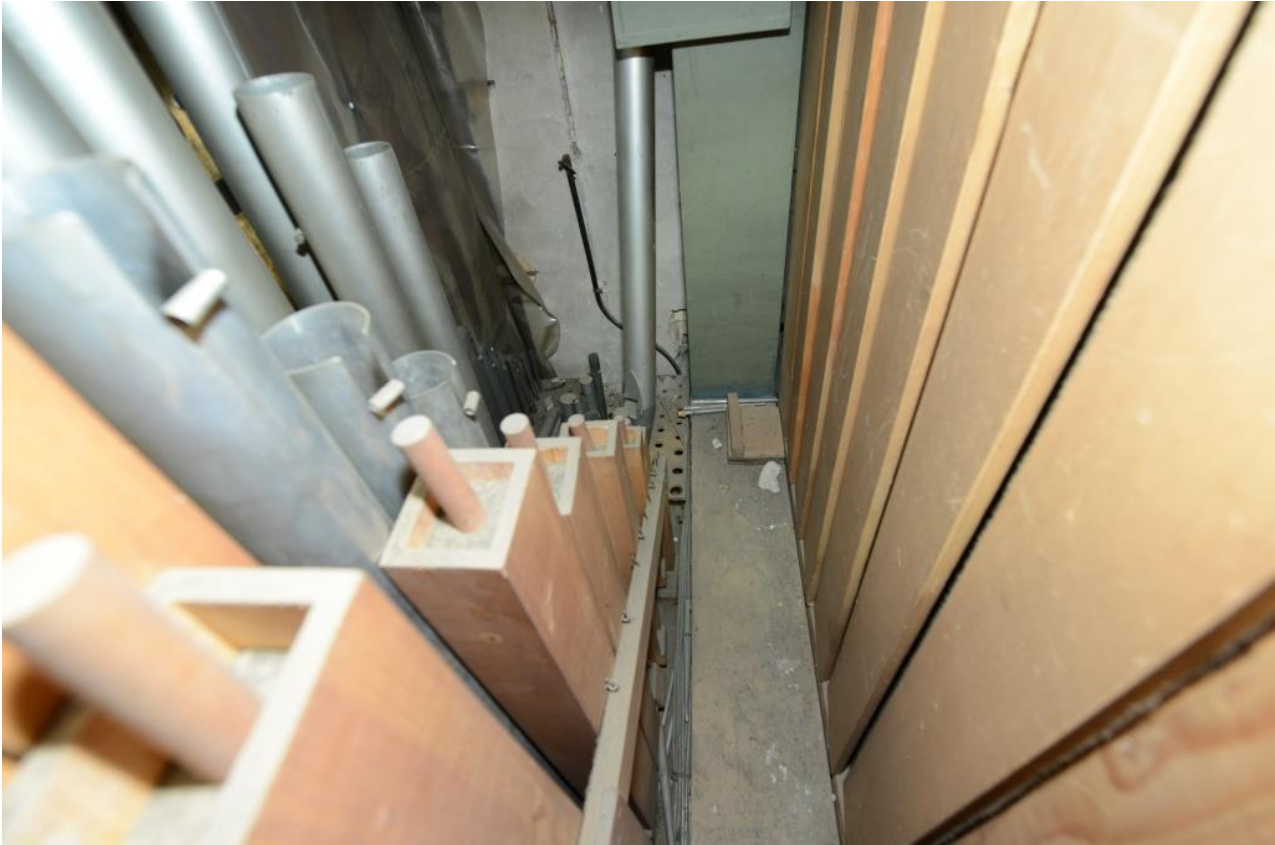
Abb. 372: Zürich ZH, das Innere des I. Manuals und die Schwellwerkjalousien in der Orgelruine im ehemaligen Kinderlehrsaal im alten Kirchgemeindehaus Neumünster (Christoph Metzler).
