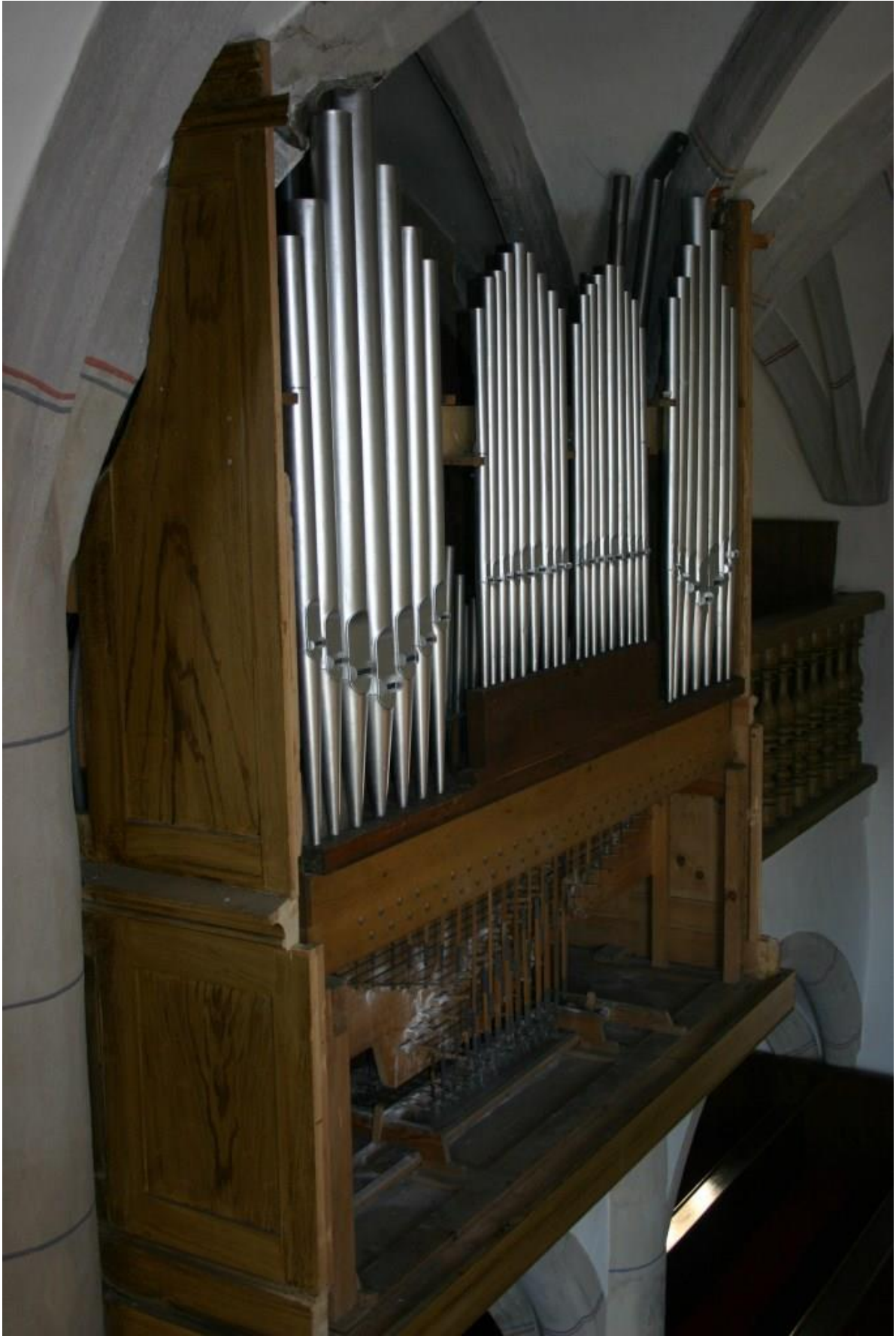
Abb. 49: Die Orgel von Max Jacob in Münichreith am Ostrong von 1904 während ihres Abbaus 2007 mit dem Wellenbrett im geöffneten Unterbau (Archiv Walter Weitzenböck, Münichreith).
