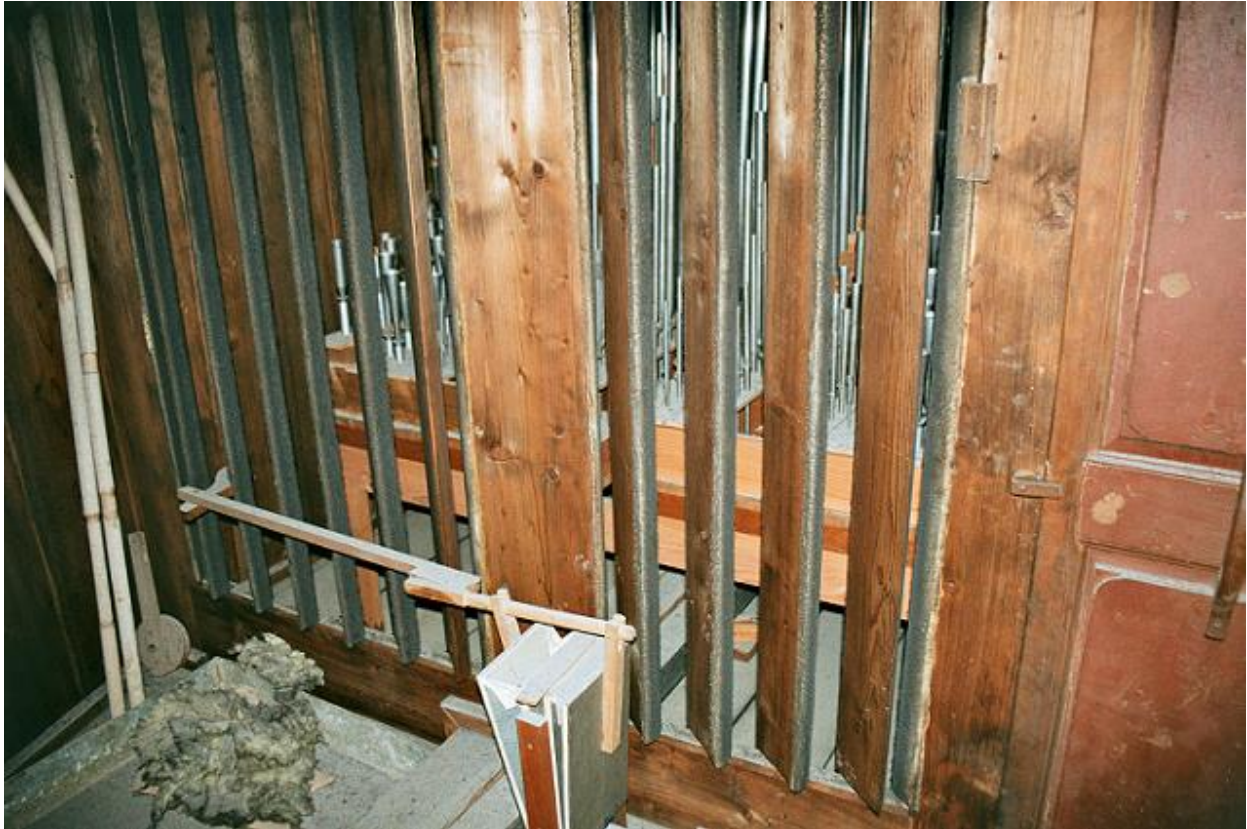
Abb. 26: Das unverändert erhaltene Fernwerk von Felix Michael Beiler von 1909 mit pneumatisch gesteuerten Jalousien im Estrich der Klosterkirche Mariastein SO (Bernhard Hörler).
