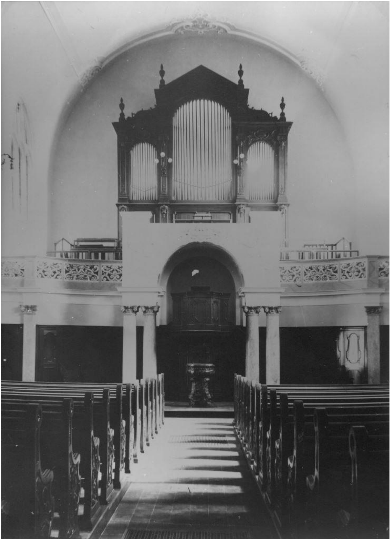
Abb. 61: Rorschach SG, evangelische Kirche (Kantonale Denkmalpflege St. Gallen).
