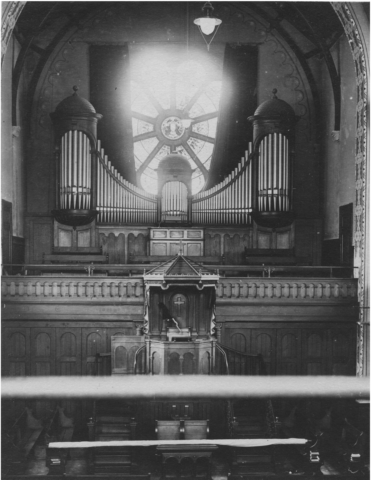
Abb. 69: La Chaux-de-Fonds NE, reformierter Temple de l'Abeille (Archiv Orgelbau Goll).
