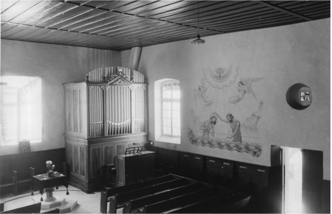
Abb. 107: Albligen BE, reformierte Kirche (Kantonale Denkmalpflege Bern, Foto von 1939).
